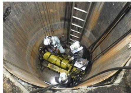
この穴から横に掘り進めながら土を出し、下水道管を入れていくという作業を左写真の機械が担っています。これは「推進工」という工法。今回の工事では、道路の上部を掘り進めて行くことの出来ない交差点部分に用いられています。他の大部分は、よく見受けられるような上から3～4m程掘って管を設置し埋戻してアスファルト舗装をする工事です。管は1本4m。それを2本繋いだ8mが一日の工事範囲。その日の作業終わりはアスファルト舗装で、なるべくみなさんの通行に支障がないように仕上げています。と、現場担当の佐野氏。
