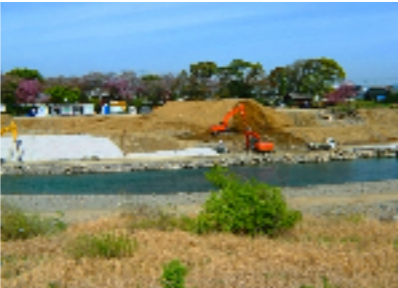
対岸から。 完成したら立派な石積み河岸です。
